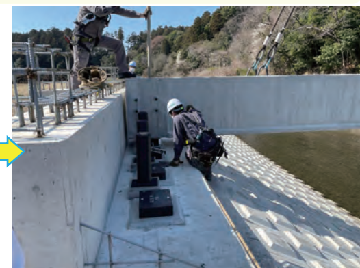
桁の設置（微調整）
