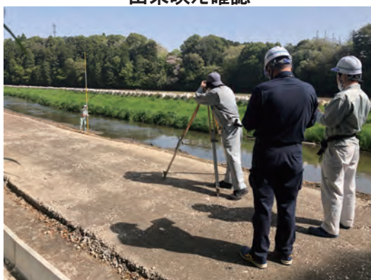
高さ検測（地盤）
