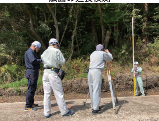
高さ検測（構造物）
