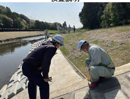
法面の延長検測
