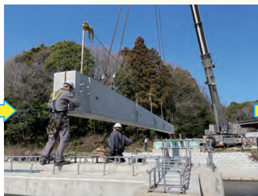
桁の設置（橋台）
