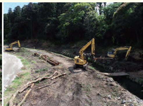
樹木伐採状況
