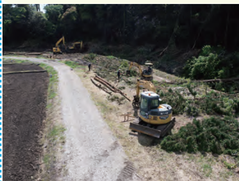
樹木伐採状況
